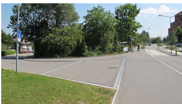
Trottoir traversant, Affoltern (ZH)
