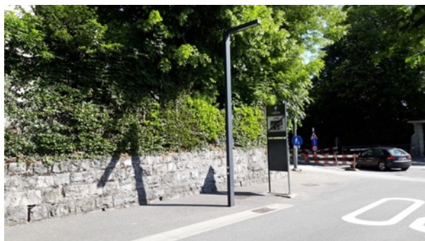
Éclairage spécifique dédié aux piétons, Versoix (GE)
