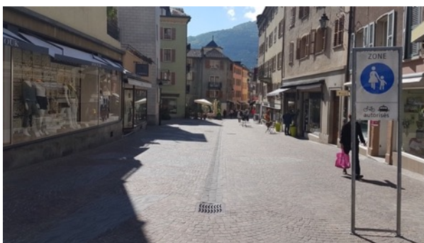
Traitement de façade à façade avec zone de rencontre, Sion (VS)
