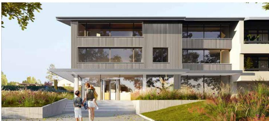
containers apposés et disposés sur un vide sanitaire. Ses façades seront agrémentées de parement en bois et le soubassement pourrait être décoré par des graffs peints par les écoliers. Le système de chauffage, alimenté par PAC, et de ventilation, a été étudié pour être réversible, tant pour des activités administratives que scolaires.
