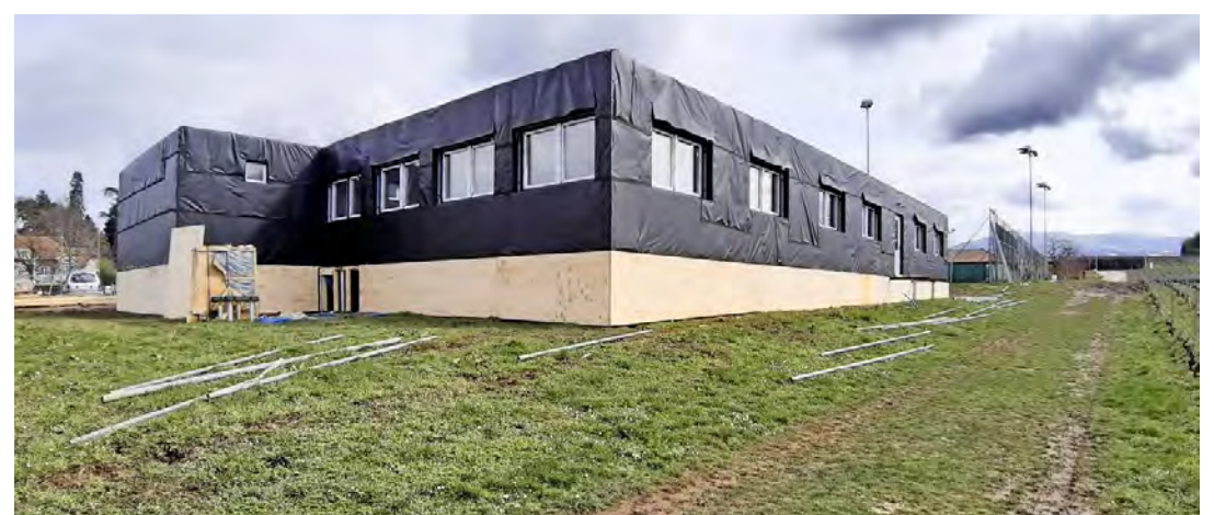
La mairie provisoire lors de sa construction. ANTOINE ZWYGART
