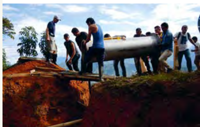
Le filtre à sable de 500 kg a été envoyé par bateau et une quinzaine de valises de 23 kg ont été nécessaires pour transporter tout le matériel : appareils pour le contrôle et l'analyse de la qualité de l'eau, outillage, pièces et autres.
