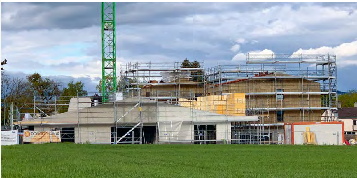
Au premier plan, le bâtiment de formation, en arrière-plan, les deux corps affectés à l'encadrement et au logement des jeunes
