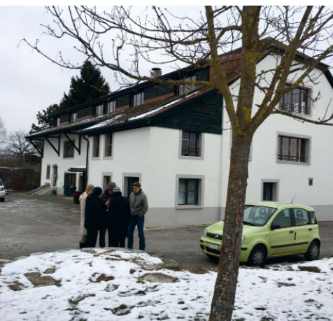
Bâtiment de l'Astural – Photos 2017
